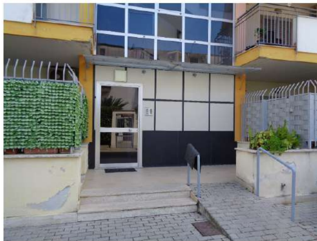
Portone d'ingresso al fabbricato
