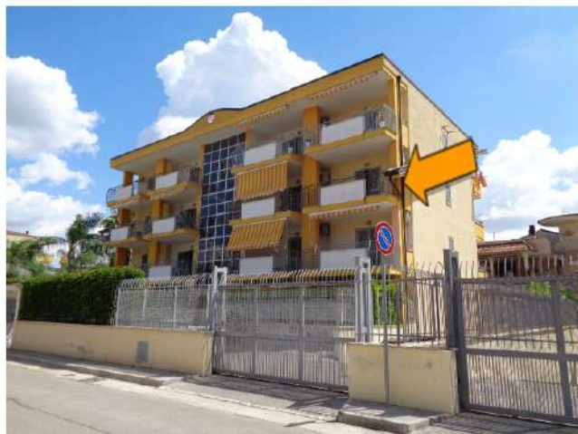
Prospetto del fabbricato da Via Salerno
